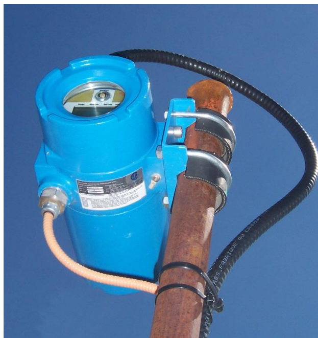
Рисунок 10-12– Крепление процессора на трубе
