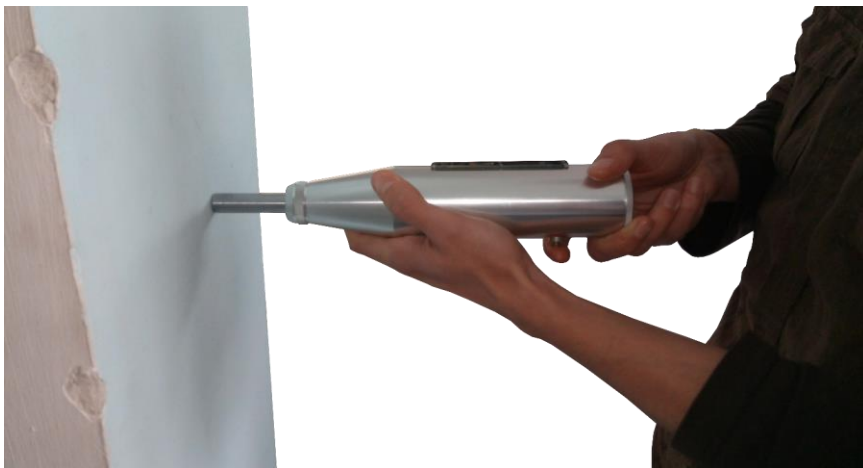
Рисунок 2.4 – Контроль прочности бетонной стены
